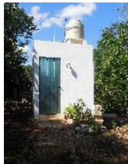
Baño ecológico con biodigestor en Calakmul.
