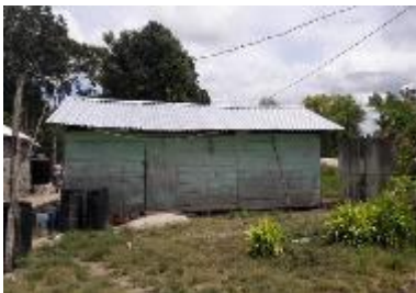
Techumbre de lámina instalada en vivienda de Calakmul.
